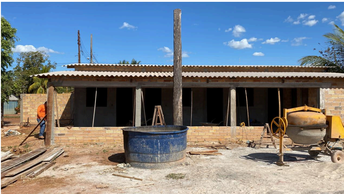
Em fase de Construção: 4 salas, area de serviços e 2 banheiros para a Secretaria de Infraestrutura e uma Sala para o Gerente de Frotas – 25/05/2022
