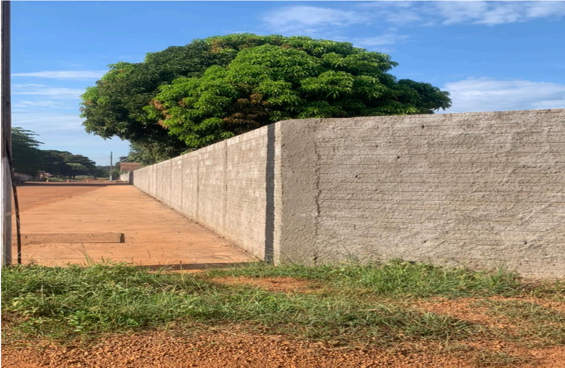
Muro construído ao redor do Patio da Secretaria de Infraestrutra, onde ficam estacionados os onibus da Secretaria de Educação e Maquinas, Caminhões e outros veiculos da Sec. De Infraestruturra – Foto: 03/05/2022
