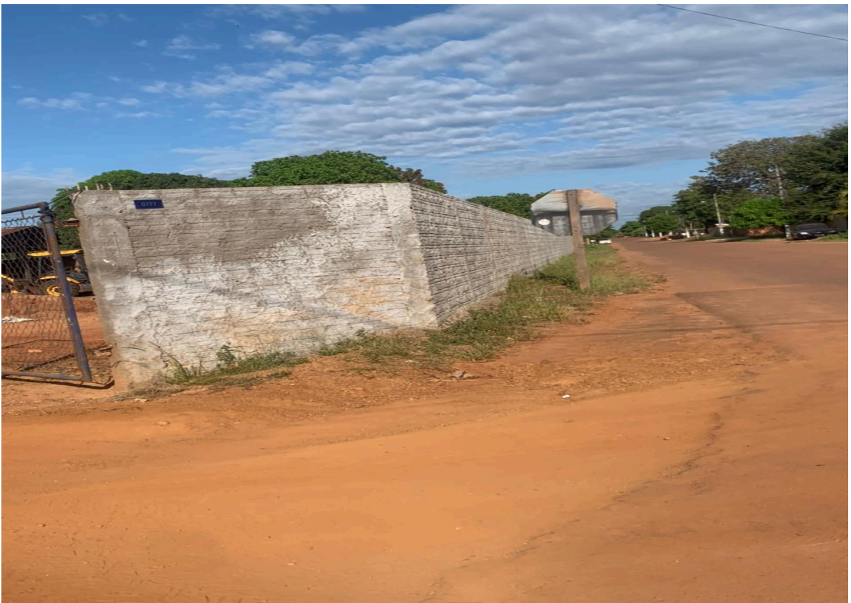
Muro construído ao redor do Patio da Secretaria de Infraestrutra
